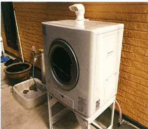
屋外 下屋 設置
